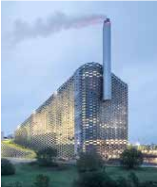
Bæredygtig kraftvarme- produktion
