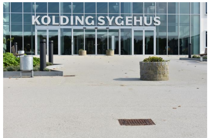
Foto: Farvet asfalt åbner op for arkitektoniske muligheder. Ved Kolding Sygehus pryder den hvide asfalt den 1442 m 2 forplads, som blev lagt i forbindelse med renoveringen og udvidelsen af sygehuset.
