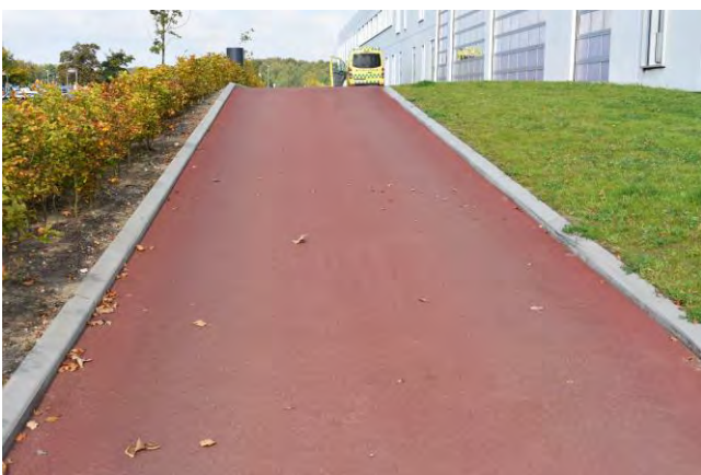
Foto: NCC har i samarbejde med M.J. Eriksson bidraget med bl.a. et rødt lag asfalt, som markerer en 1700 m 2 ambulancevej ind til Kolding Sygehus, og et hvidt slidlag med klar bitumen, der pryder den 1442 m 2 plads ved hovedindgangen.
