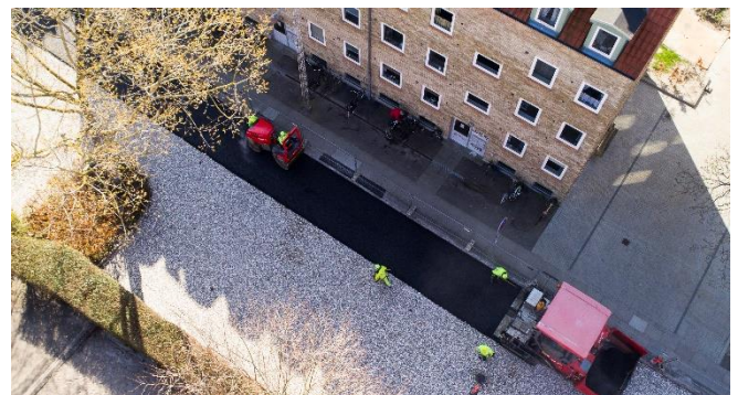
AkvaVejen i Taarnby – Danmarks første NCC PermaVej® med integreret rensningsanlæg.
